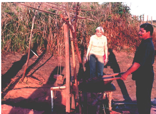
Figura 57: Suprindo o ar para o escavador
