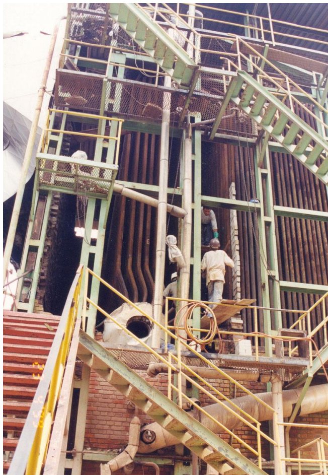
Foto 16: refazendo a cobertura refratária do edifício das caldeiras
