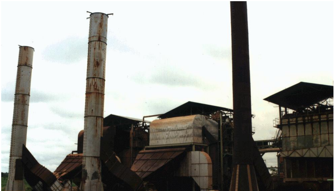
Foto 19 – ...as caldeiras que produzirão vapor superaquecido que irá...
